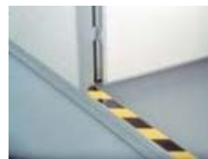
Nizek prag - le 70 mm - je markiran z dobro vidnimi debelimi rtami.
